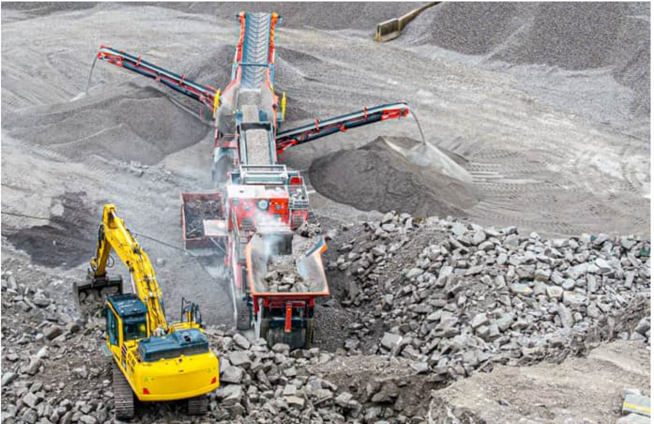
Ein wichtiger Schritt zur Ressourcenschonung: A1 Schmittenhäusl, die Betonrecyclinganlage gewinnt aus Abbruchmaterial hochwertiges Recyclingmaterial.
